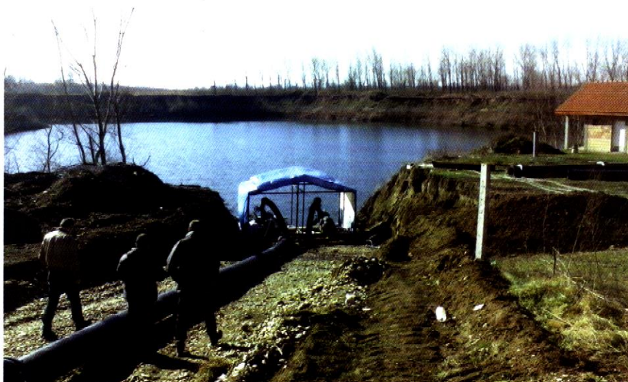
Slika 4. Škarpa do jezera (šljunkare) sa cevovodom i crnim agregatima za nalivanje infiltracionih bazena (foto dokumentacija SOT-a, 14.11.2015)
