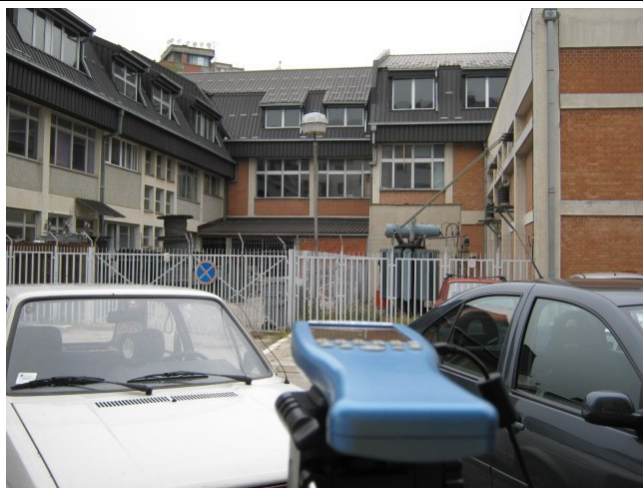
Мерна тачка Т3 Лимска 25, између трансформатора и стамбене зграде, 17 m од трафоа
