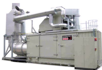
Слика 5.26 Изглед постројења за комбиновану производњу електричне и топлотне енергије
