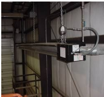
Слика 5.22 Инфрацрвено грејање просторија
