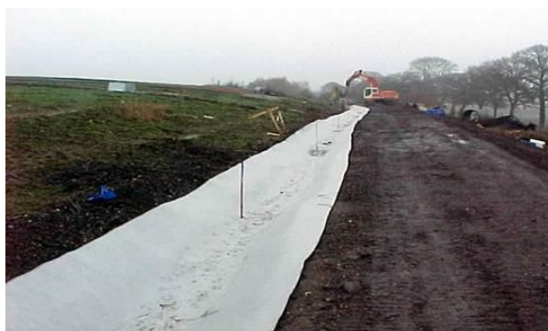
Слика 6.7 Приказ депоније са ободним каналима за отицање воде са фолије
