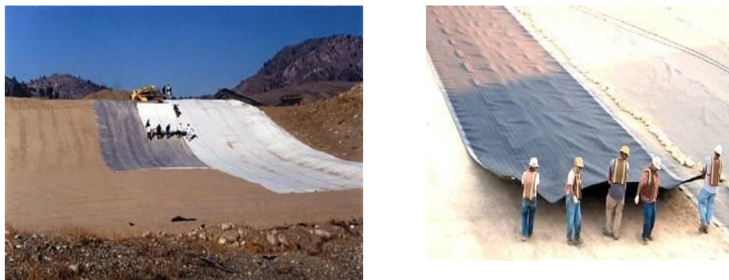
Слика 6.9 Постављања доње непрпусне фолије.
