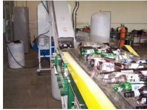
Слика 5.8 Постројење за рециклажу стакла
