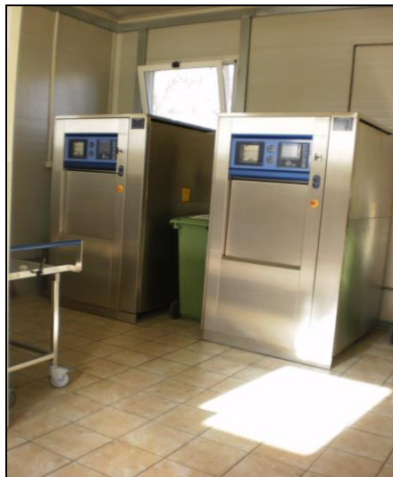
Слика 28. Аутоклав за стерилизацију
