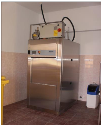
Слика 26. Аутоклав за стерилизацију инфективног отпада
