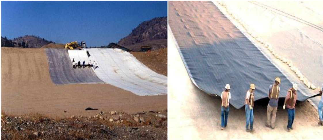
Слика 5.12. Постављања доње непропусне фолије.
