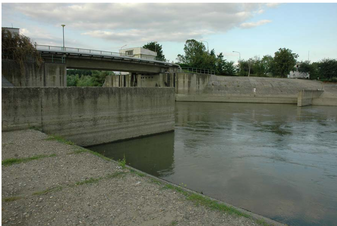
Слика 2 – Устава на Тамишу код Опова
