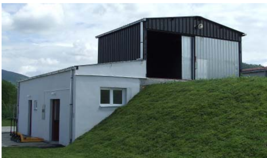
Слика 62 - Сабирни пункт (хладњача) за привремено складиштење кланичког отпада у Вршцу
