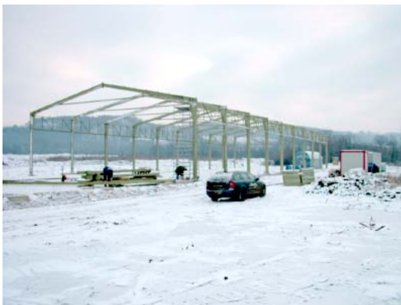
Слика 18 - Подизање конструкције хале за сепарацију отпада
