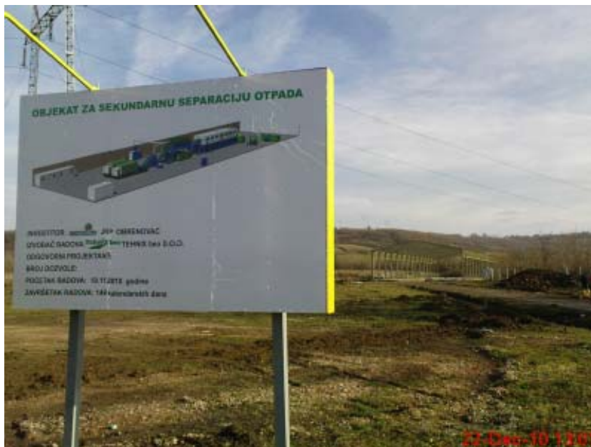
Слика 17 - Градилишна табла на градилишту објекта центра
