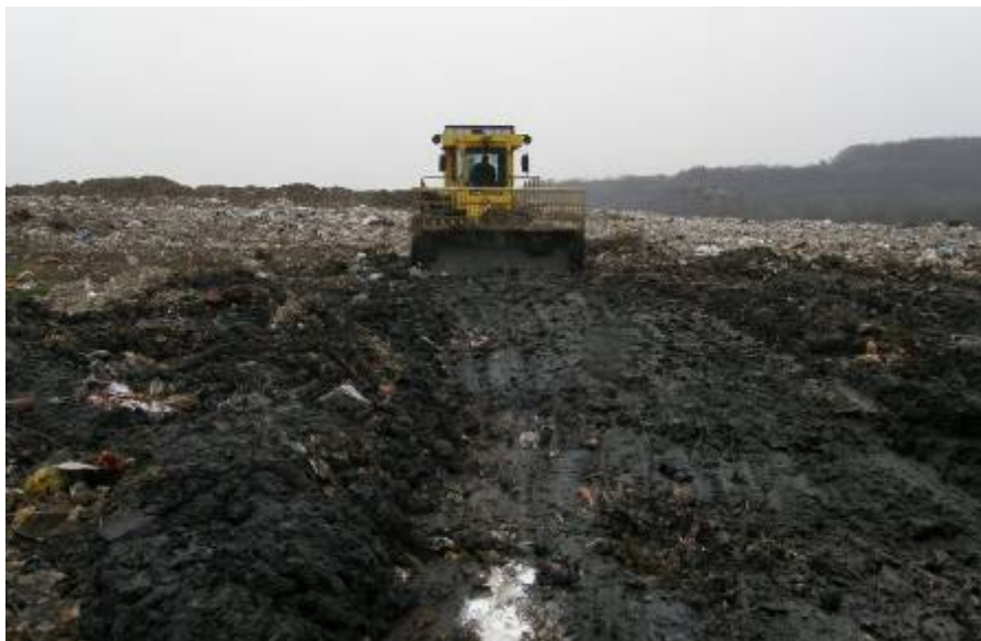
Слика 20 – Компактирање отпада на депонији "Гребача"
