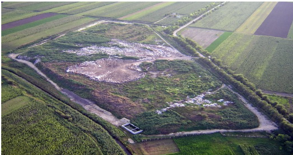
СЛИКА бр. 7: Општинска депонија комуналног отпада у Ади
